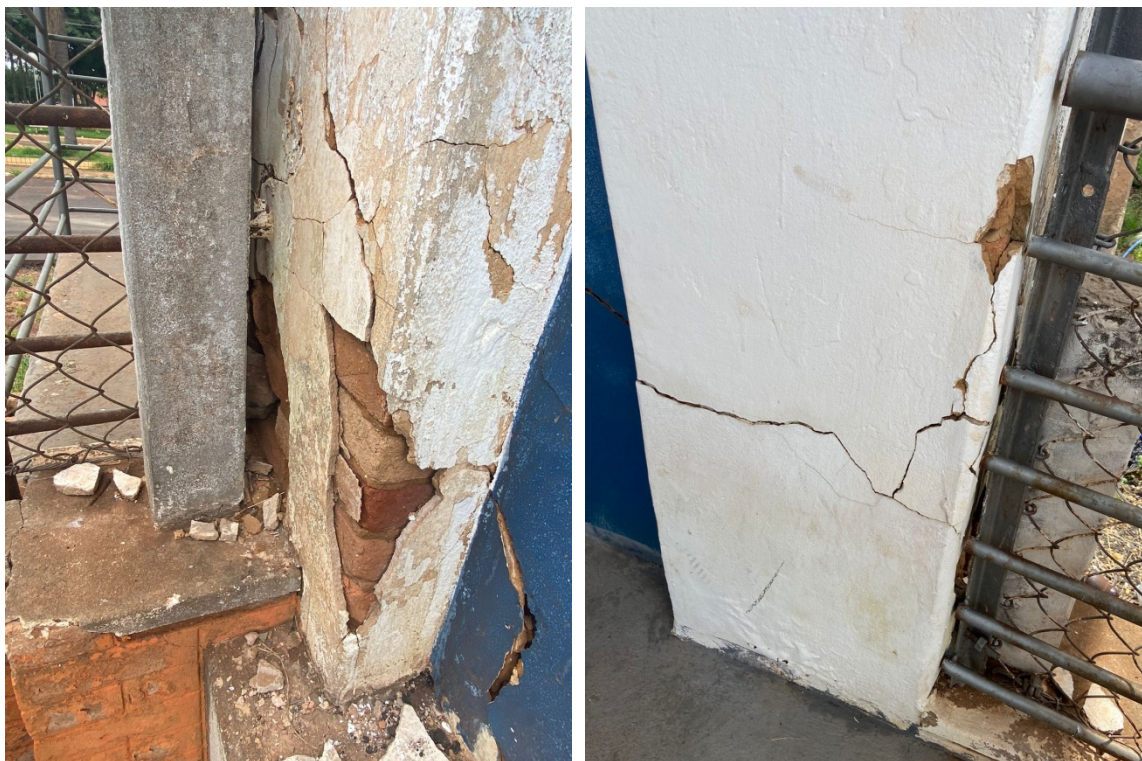
Figura 8 - Pilar comprometido
