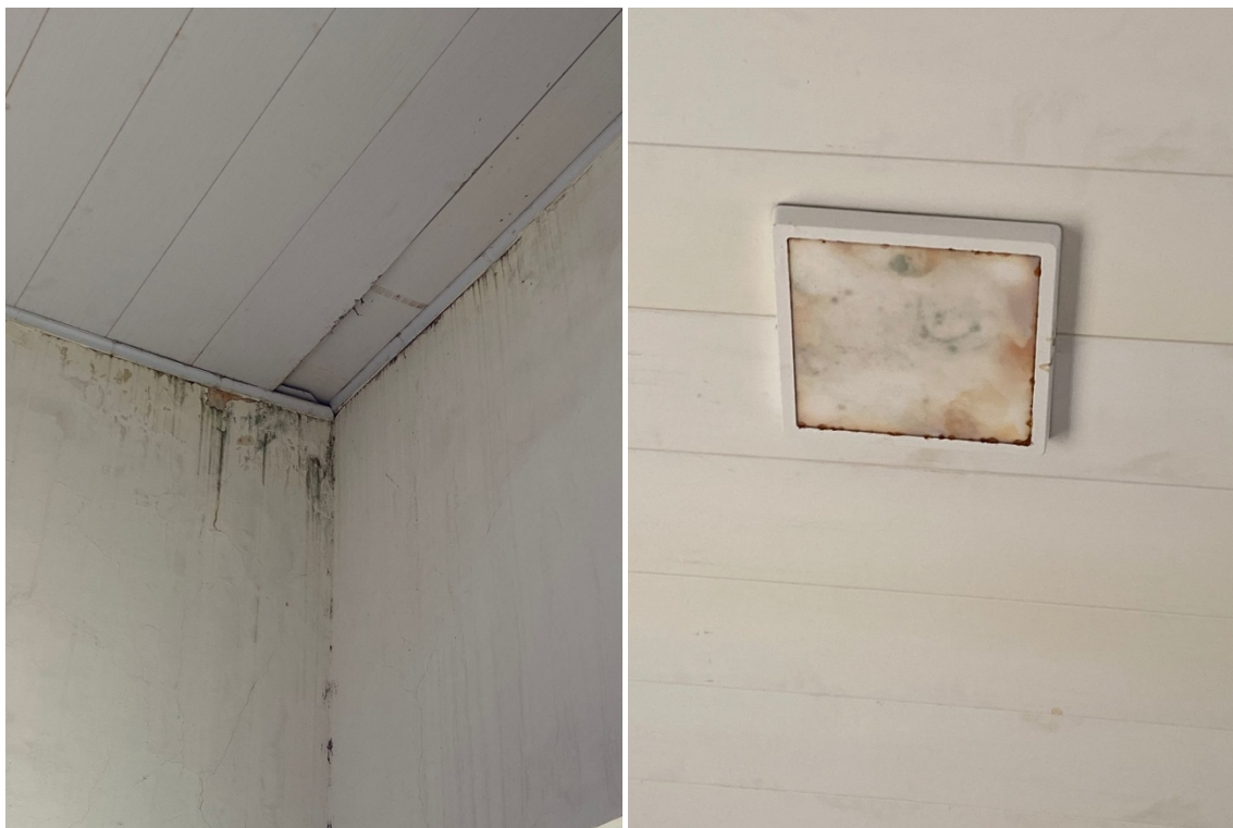
Figura 6 - Infiltração pela cobertura
