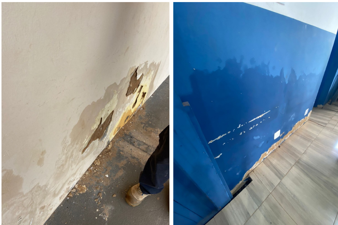
Figura 12 - umidade ascendente
