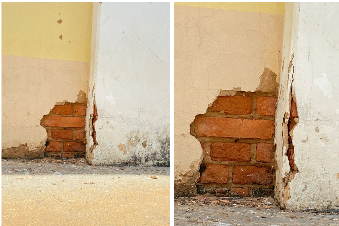
Figura 9 - Pilar com degradação
