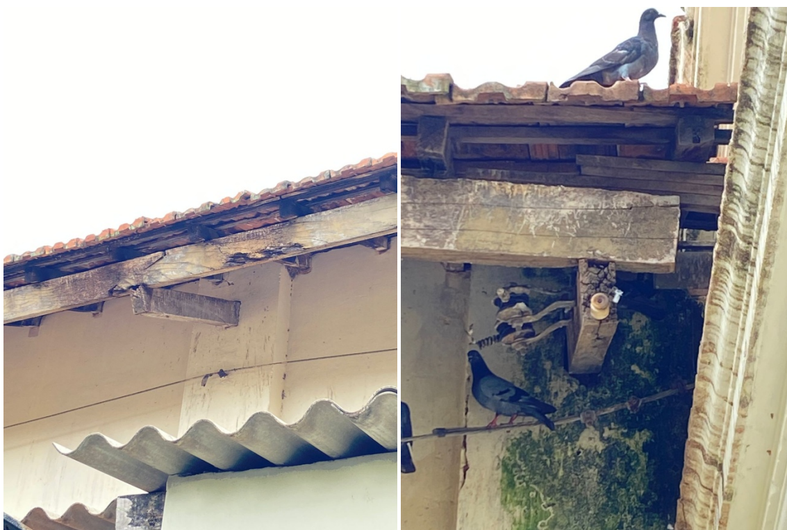
Figura 2 - Madeiramento externo apodrecido
