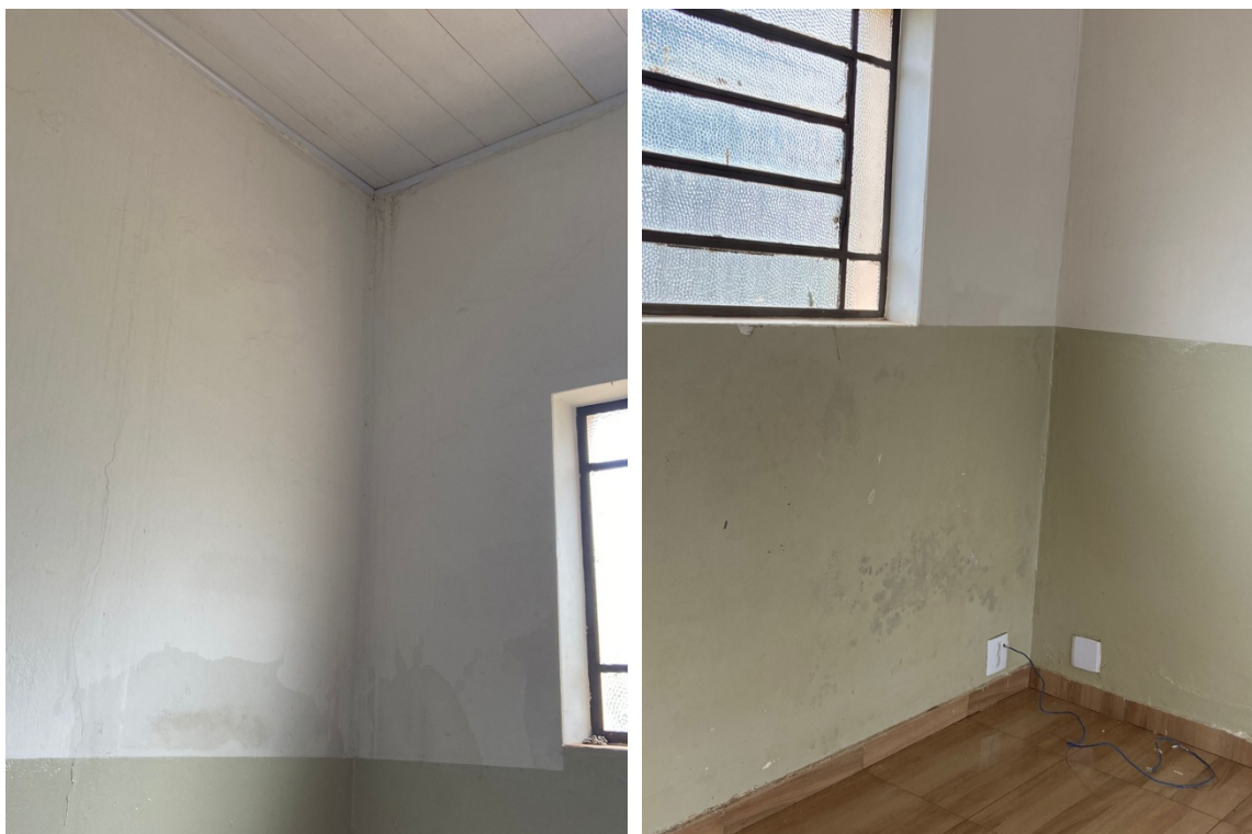
Figura 13 - umidade interna
