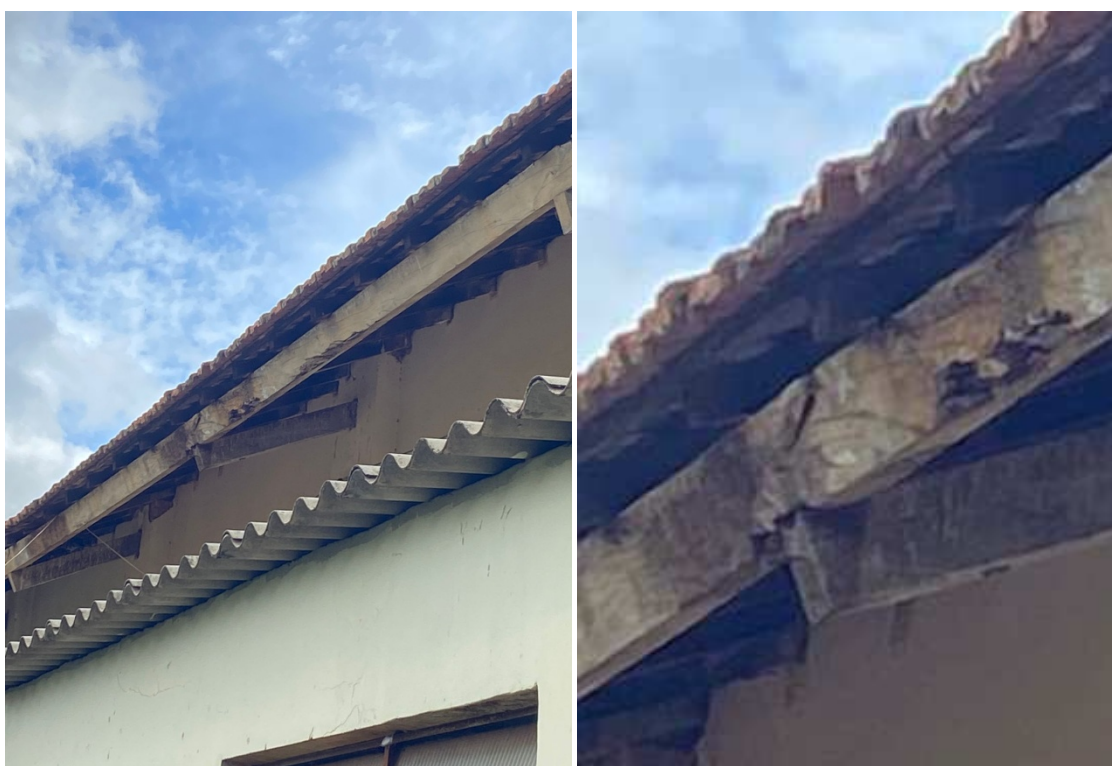
Figura 4 - Madeiramento externo comprometido
