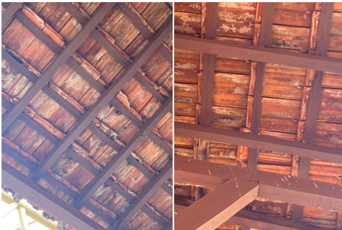
Figura 7 - telhamento da varanda apresentando sinais de degradação
