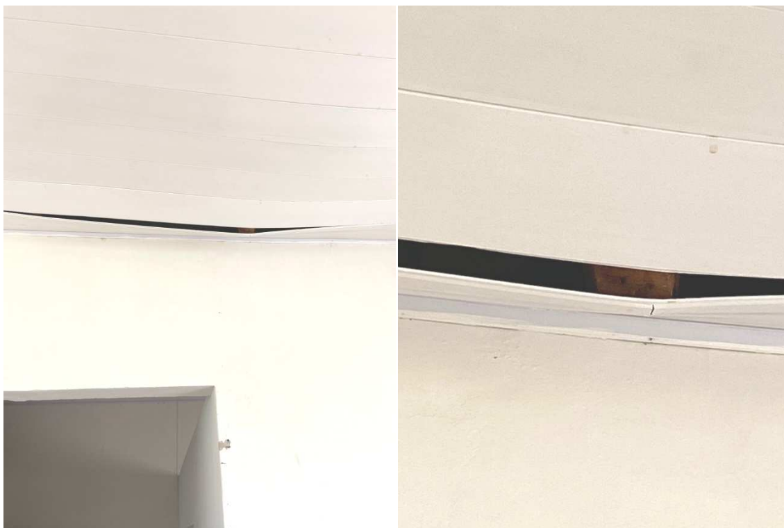
Figura 3 - Forro da sala do SAD onde se observa o colapso de elementos da cobertura
