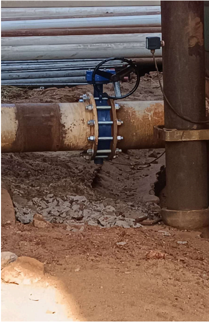
Foto 32 - Válvula borboleta linha de transferência
