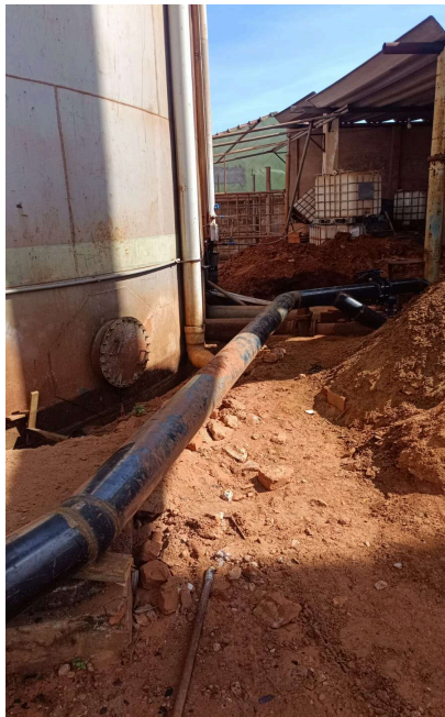
Foto 34 - Nova linha de sucção
