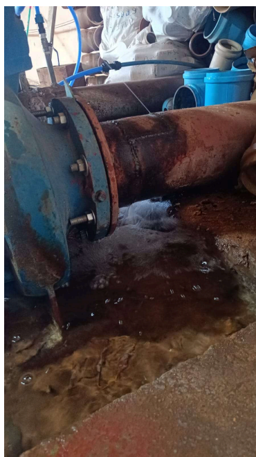
Foto 13 - Vazamento sucção
