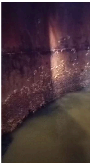
Foto 1 - Situação interna reserva CDR01
