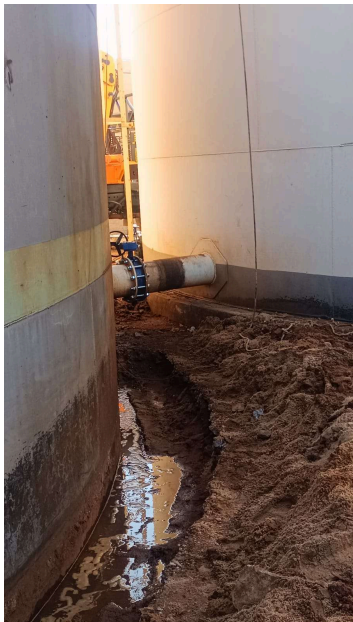
Foto 12 - Inspeção vazamento costado
