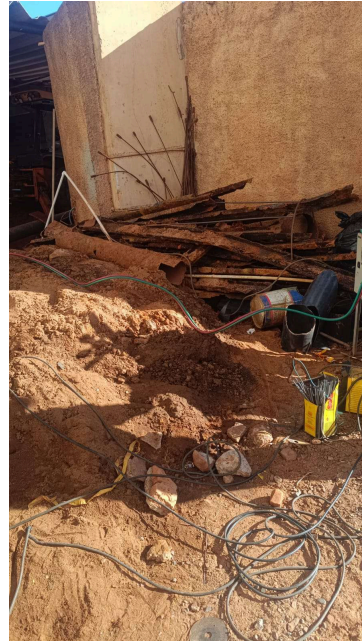
Foto 23 - Sujidade retirada do reservatório
