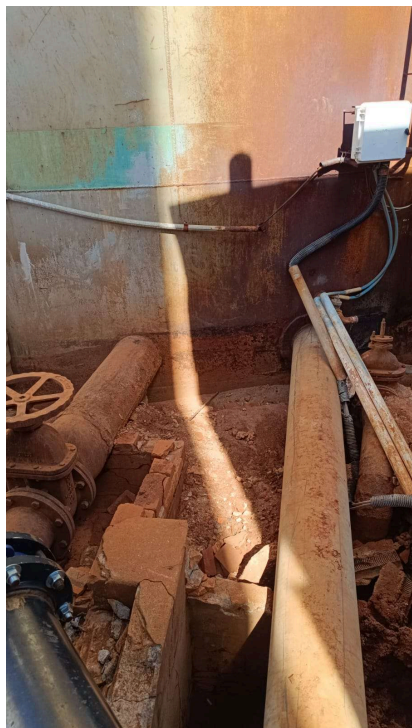
Foto 38 - Nova linha de sucção após reparo
