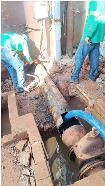
Foto 4 - Situação costado inferior
