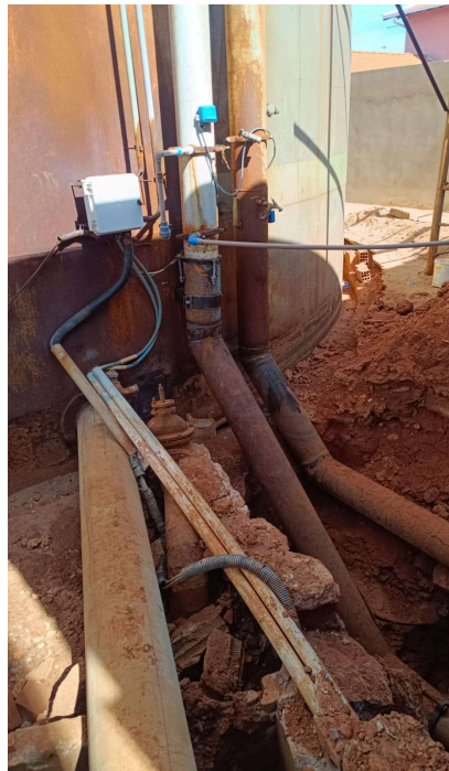
Foto 35 - Nova linha de sucção após reparo
