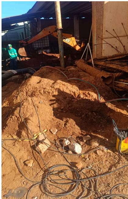
Foto 26 - Sujidade retirada reservatório
