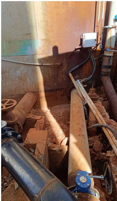
Foto 36 - Nova linha de sucção após reparo
