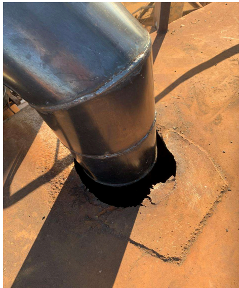
Foto 27 - Situação teto reservatório
