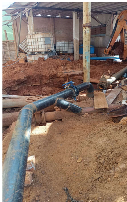
Foto 33 - Nova Linha de sucção
