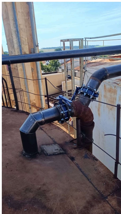
Foto 42 - Interligação recalque P07
