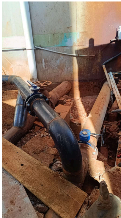
Foto 37 - Nova linha de sucção após reparo
