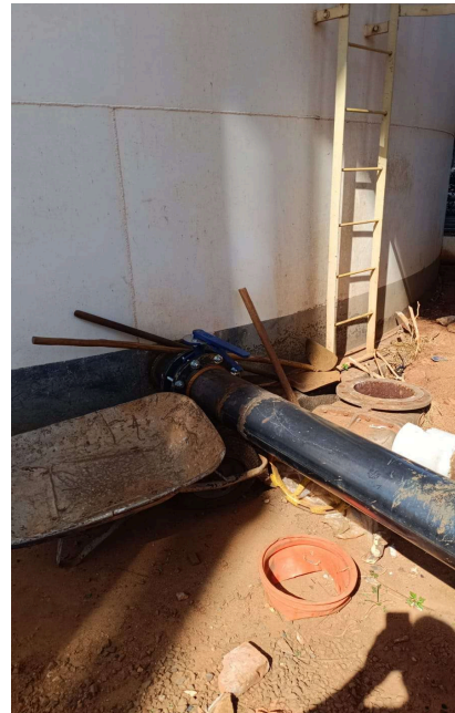
Foto 31 - Nova linha de sucção
