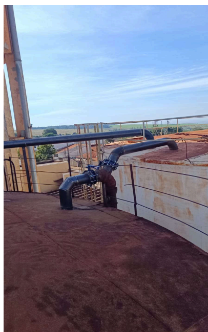
Foto 39 - Interligação Recalque P07
