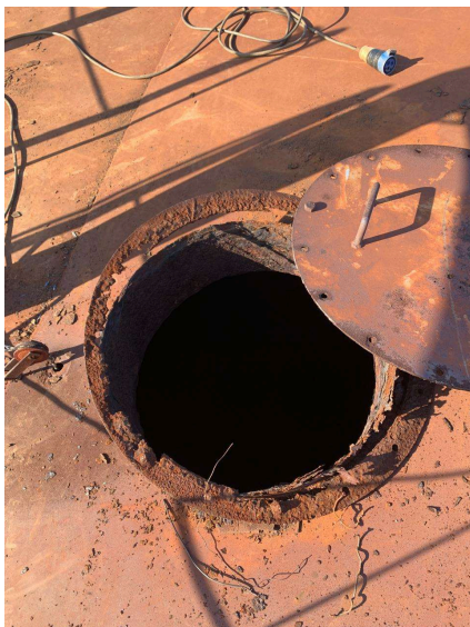
Foto 28 - Situação boca de visita teto
