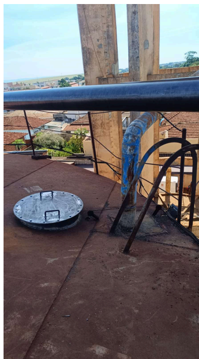
Foto 41 - Nova Boca de visita
