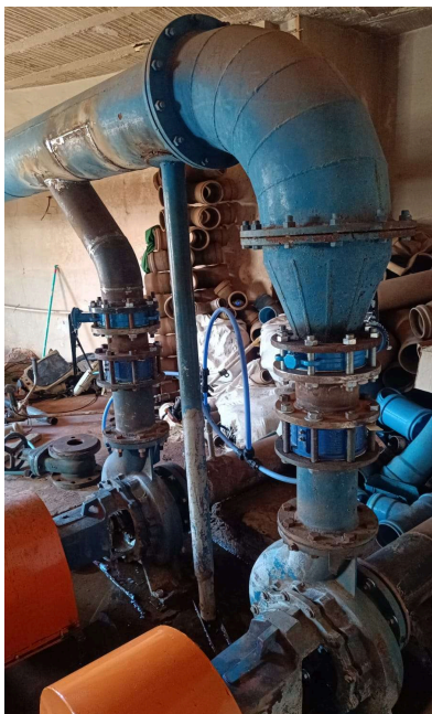
Foto 46 - Adequação sentido de recalque, válvula borboleta, válvula retenção
